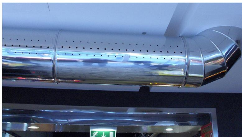
**Nota:** I collari di giunzione sono attualmente disponibili solo in acciaio inox 304 finitura lucida e acciaio 2B opaco. Possono essere ulteriormente protetti mediante verniciatura trasparente in casi di ambienti particolarmente aggressivi.
