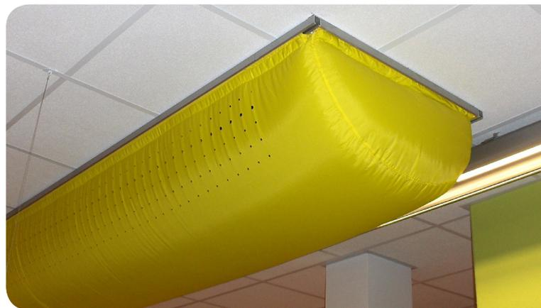
Un canale utilizzato sia per il riscaldamento che per il condizionamento sarà giocoforza un compromesso tra due tipi di foratura.
