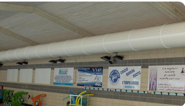
La verniciatura a liquido è generalmente usata quando i canali vengono verniciati in opera, dopo il montaggio, ma in alcune circostanze viene espressamente richiesta all'origine.
