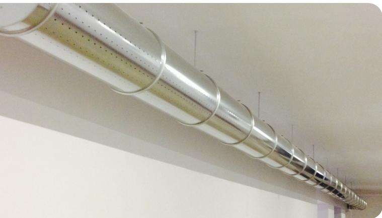
Da un punto di vista pratico la lamiera zincata è un ottimo materiale anche in ambienti clorini quali piscine ad acqua dolce, dove l'azione corrosiva dell'acqua e dei sali di calcio e di magnesio in essa normalmente disciolti, favorisce la passivazione dello zinco superficiale ossia la formazione di uno strato di ossido inerte ed insolubile che protegge lo zinco stesso da un conseguente contatto con gli agenti aggressivi ambientali.
